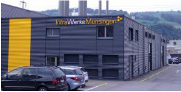
Die 2015 erstellte Energiezentrale mitten im Perimeter des Wärmeverbands Süd nutzt Erdgas als Energiequelle für die Wärme- und Stromproduktion.
