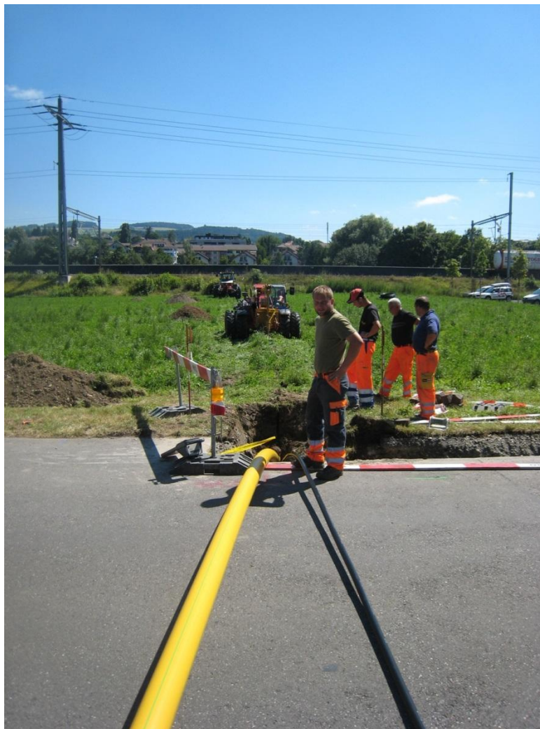
Bild 7: Einpflügen Erdgasleitung
