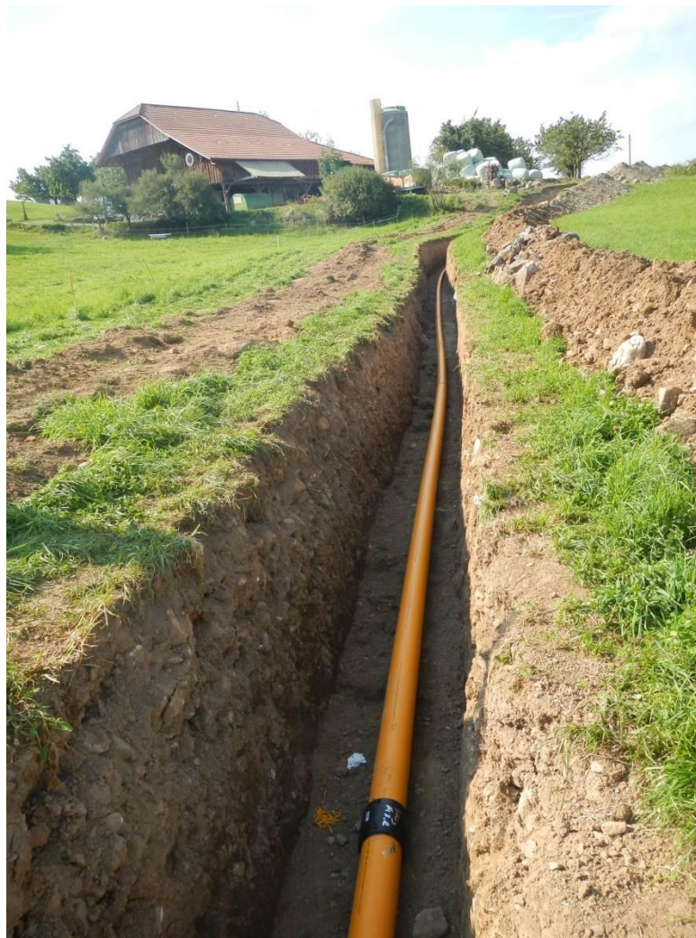
Bild 4: Verlegte Leitung im Graben
