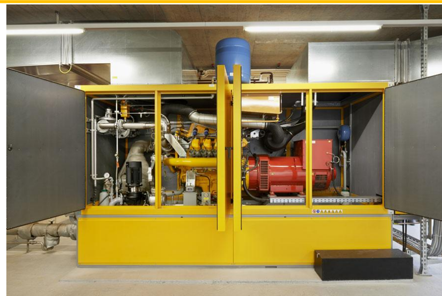
Prinzipdarstellung eines Blockheizkraftwerkes
