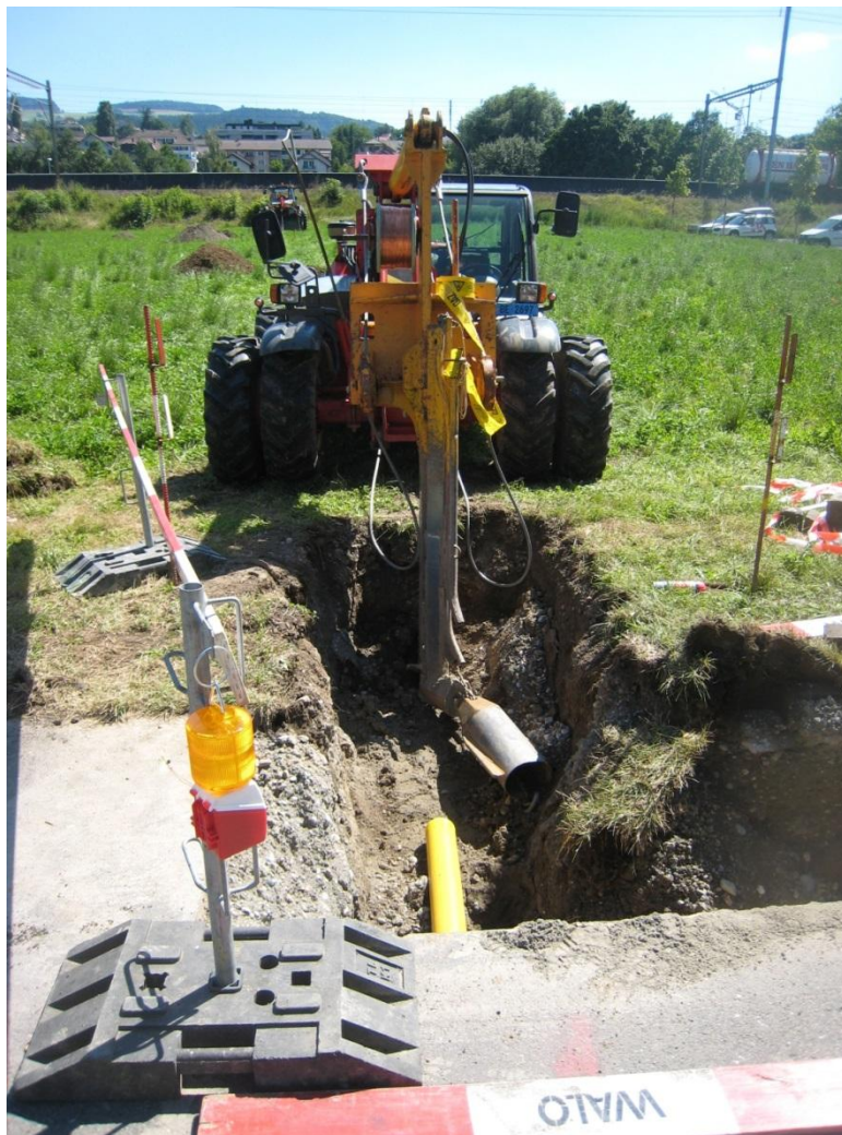
Bild 6: Einpflügen Erdgasleitung
