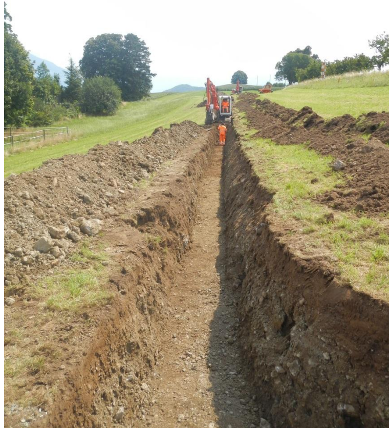
Bild 2: Erstellen des Grabenprofils
