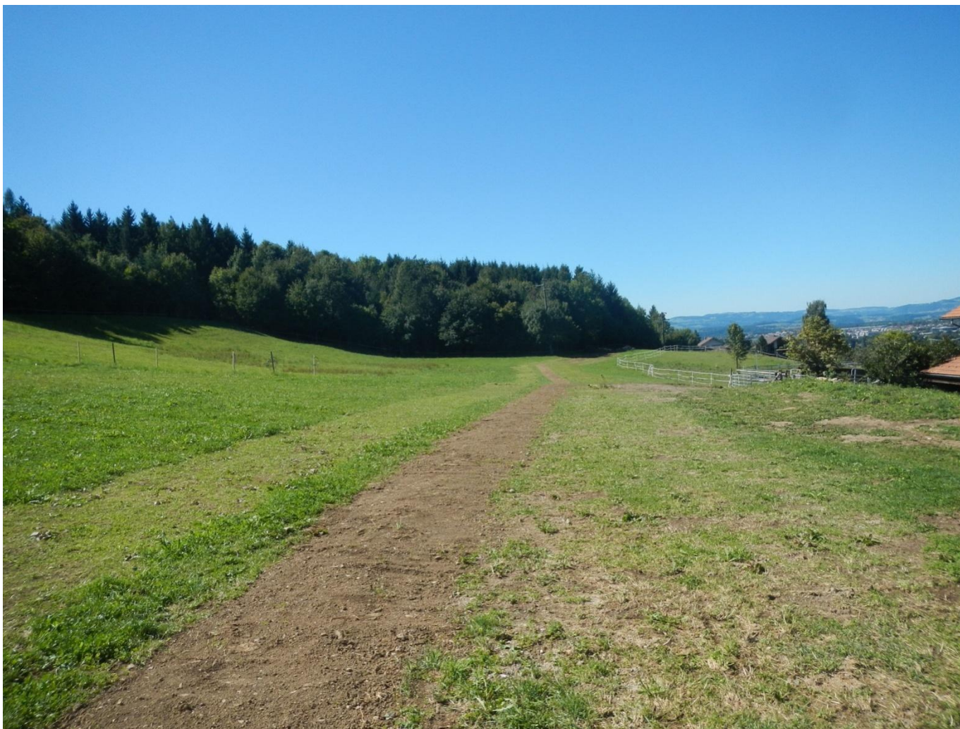
Bild 5: Verfüllter und anhumusierter Leitungsraben
